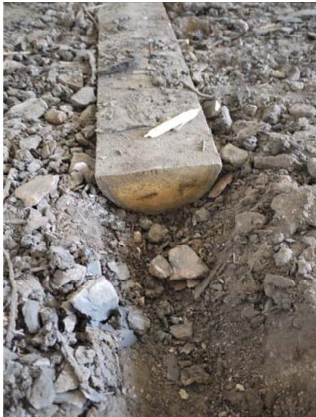
Abbildung 5-10: Fußbodenkonstruktion mit Schlacke und Polsterholz
