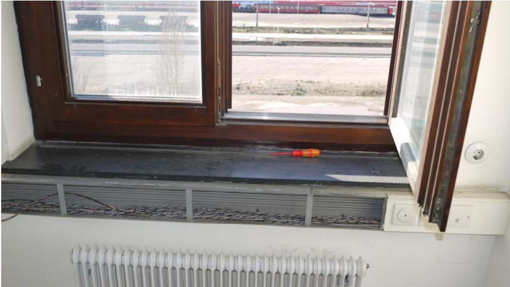
Abbildung 5-33: Asbesthaltige Fensterbank
