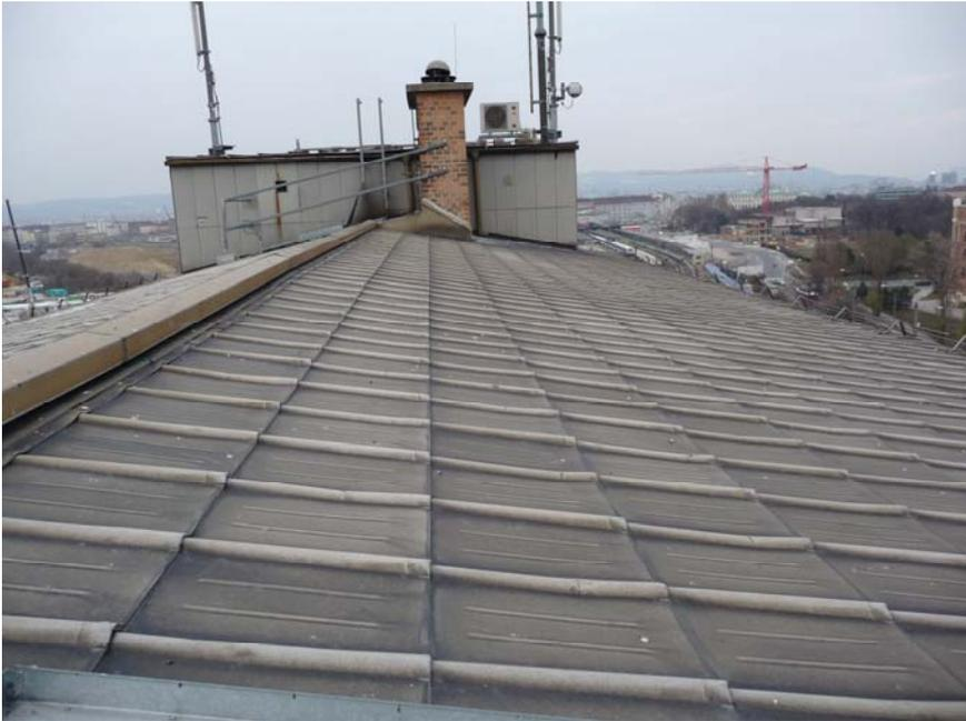
Abbildung 5-31: Dachschindeln aus Aluminium
