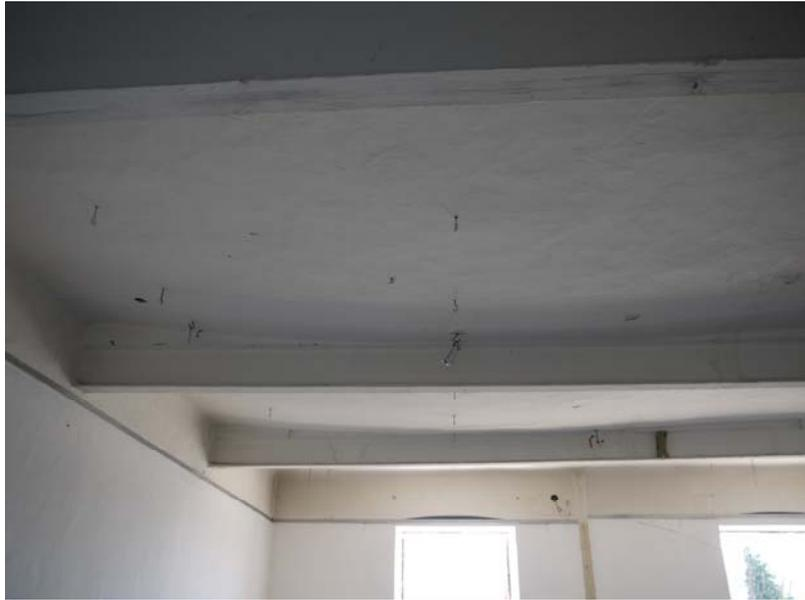
Abbildung 5-5: Eingezogene Stahlträger zur Verstärkung der 1. Geschoßdecke
