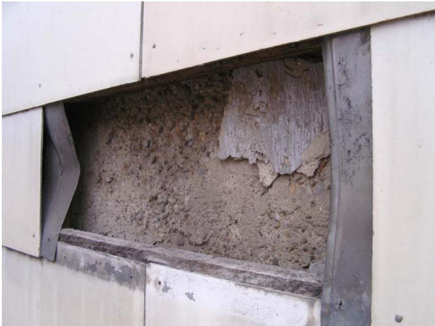
Abbildung 5-47: Fassadenbekleidung aus Faserzementplatten (asbesthaltig)
