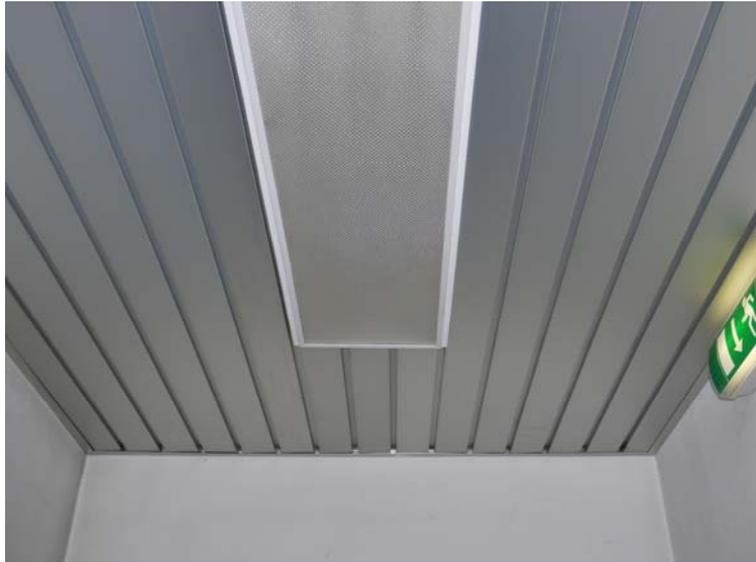
Abbildung 5-29: Zwischendecke aus Stahlblech
