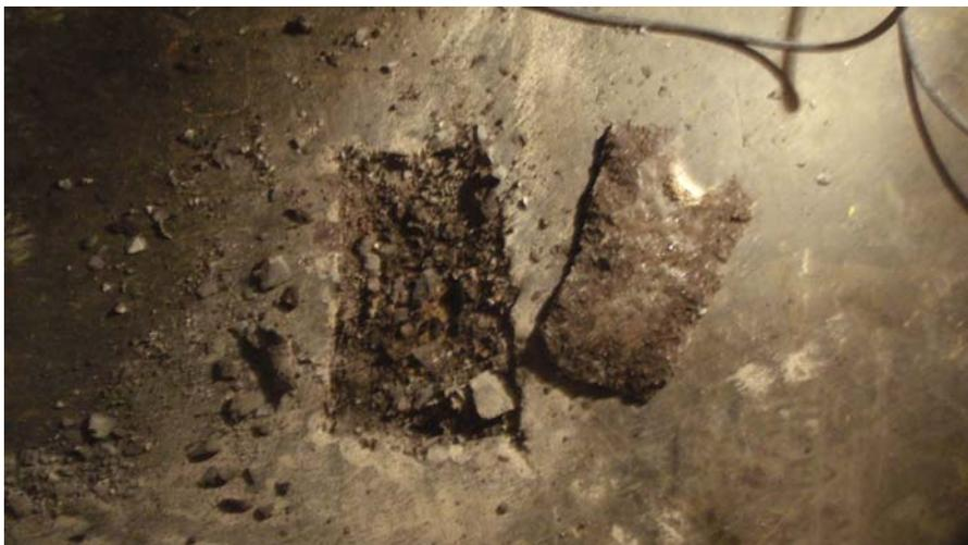
Abbildung 5-36: Gussasphalt im Kellerbereich
