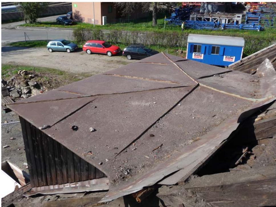
Abbildung 5-6: Eindeckungen mit verzinktem Stahlblech im Dachbereich (Gaupe)
