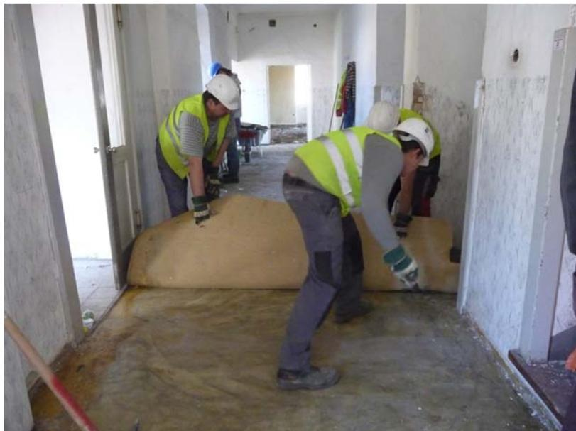
*Abbildung 5-7: Rückbau von Kunststoffbodenbelägen*
