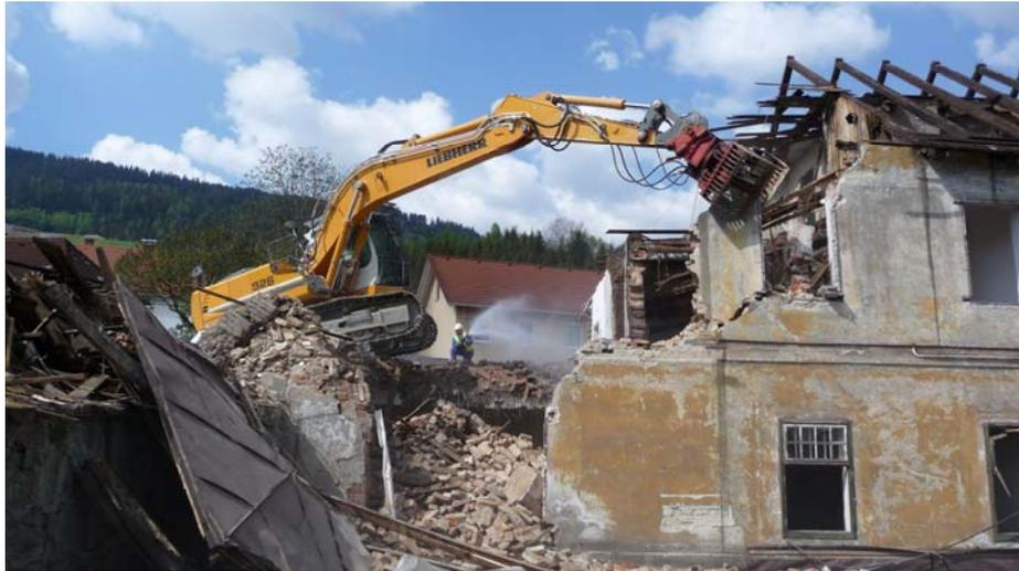
*Abbildung 5-22: Abgreifen der Ziegelmauer*
