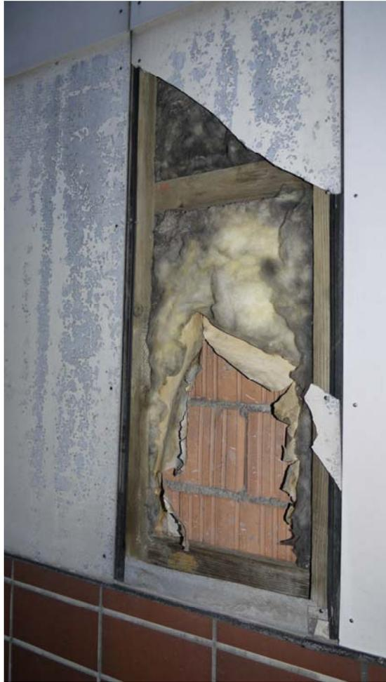
Abbildung 5-32: Fassadenverkleidung aus Faserzementplatten (mit Dämmung aus Glaswolle)
