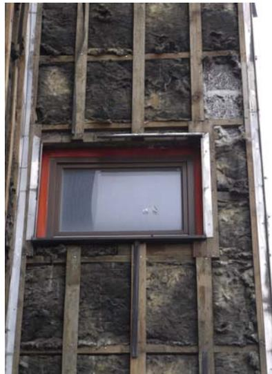
Abbildung 5-27: Holzlatten im Fassadenbereich
