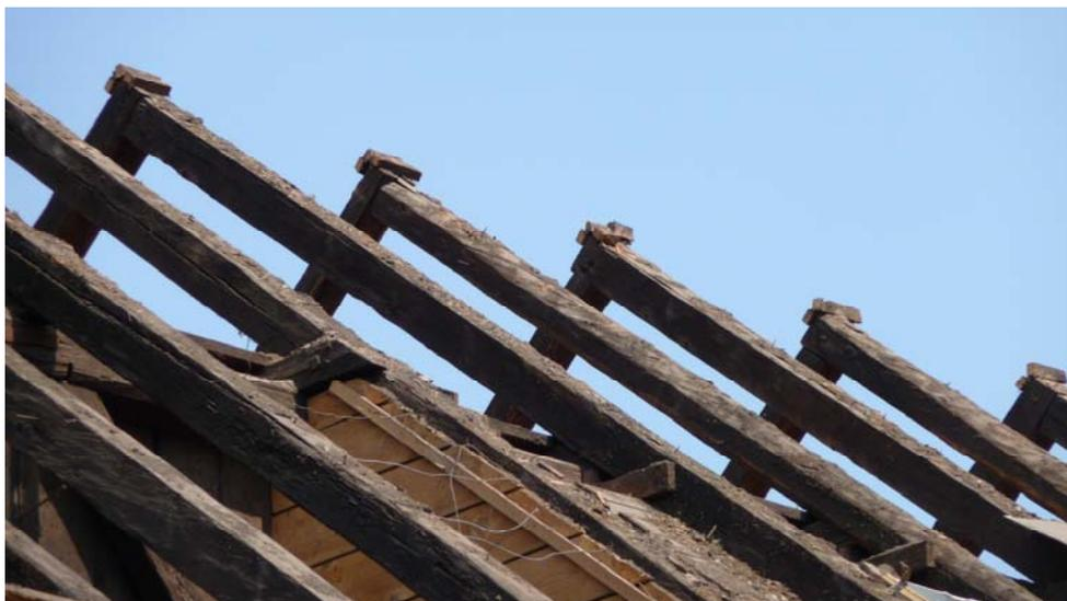
Abbildung 5-9: Holzdachstuhl ohne Dachdeckung (selektiver Rückbau)
