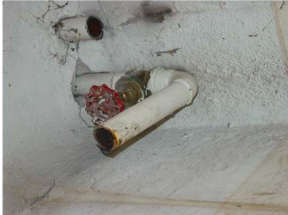
Abbildung 5-18: Abgetrennte Rohrleitungen
