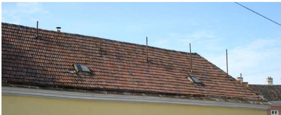
Abbildung 5-46: Dachdeckung aus Dachziegel
