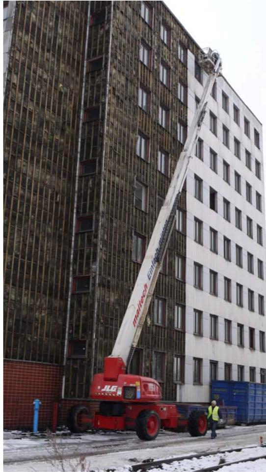
Abbildung 5-38: Selektiver Rückbau der Fassade aus Faserzementplatten
