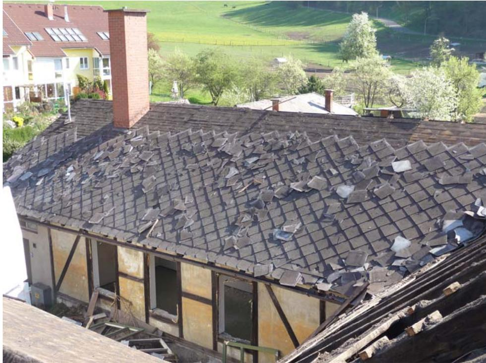
Abbildung 5-13: Faserzementplatten im Bereich des Zubaus (Küche und Sanitärbereich)
