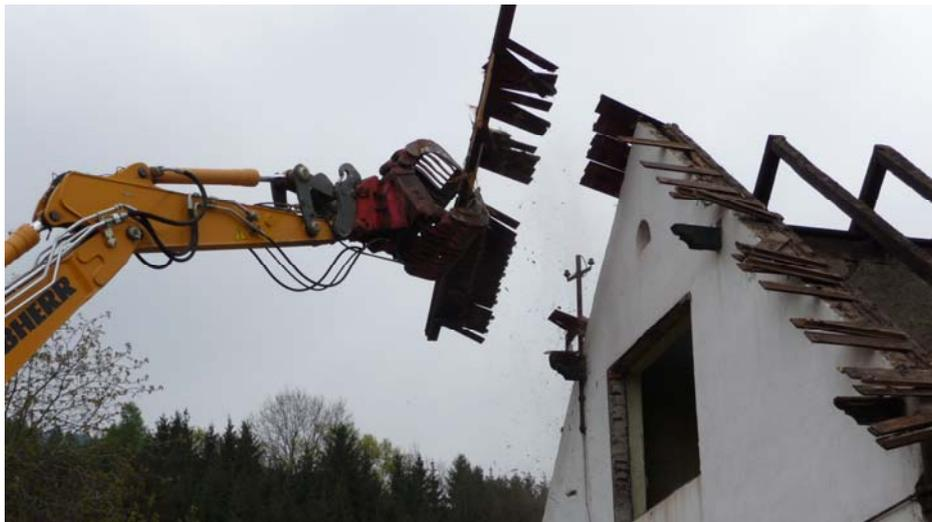
Abbildung 5-15: Abgreifen von Dachsparren
