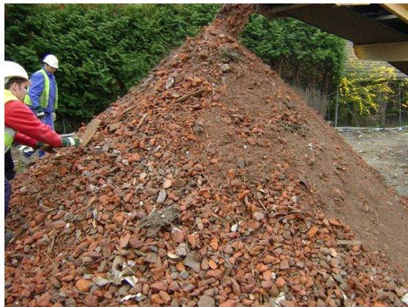
Abbildung 5-24: Händische Sortierung von Störstoffen
