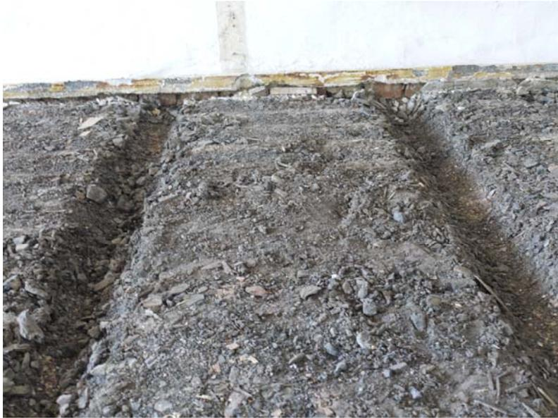
Abbildung 5-12: Schlackenschüttung im Fußbodenbereich
