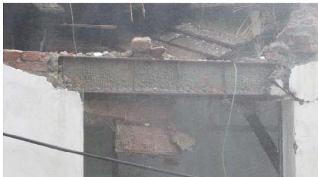
Abbildung 5-20: Eingezogenes Stahlüberlager (Abbruch)
