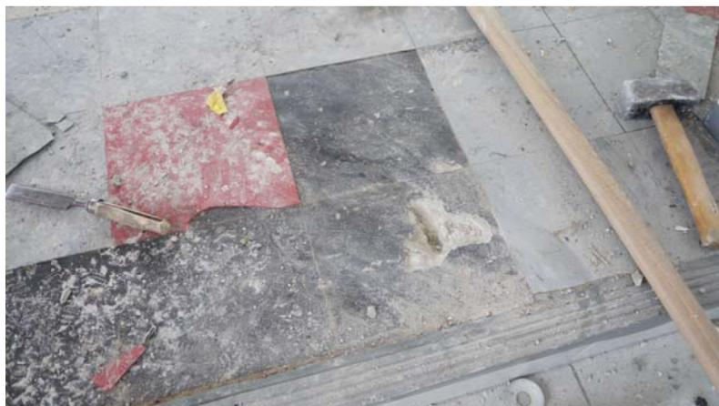
Abbildung 5-48: Asbesthaltiger Fußbodenbelag
