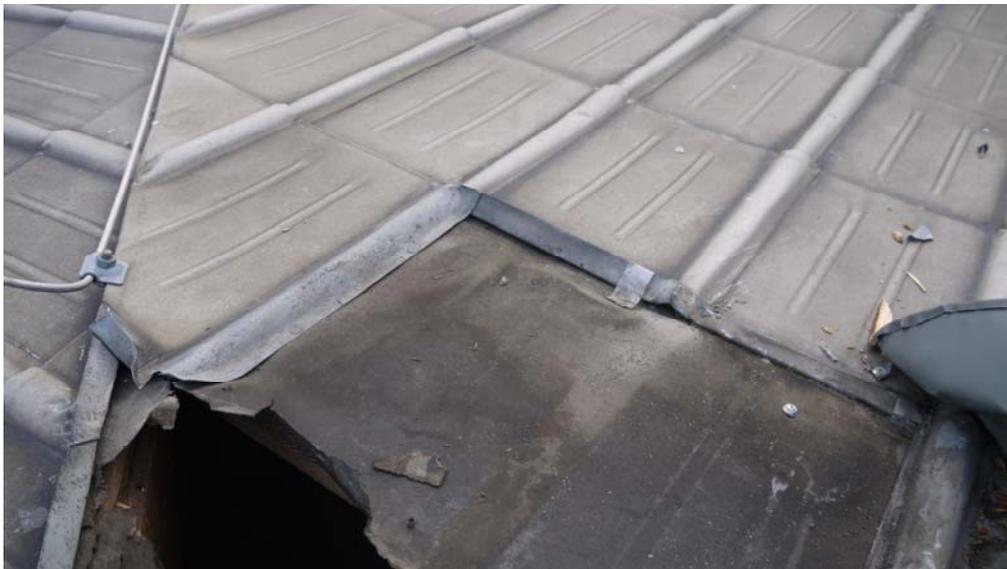
Abbildung 5-34: Teerpappe unter Alu-Dachschindeln
